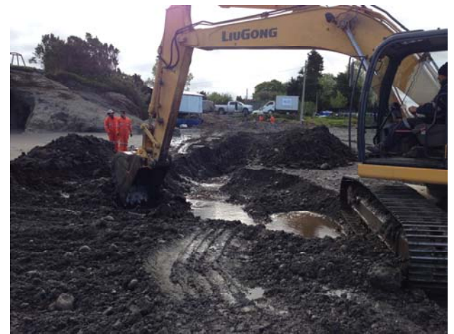
En etapa de enterrar el cable – Quellón.
