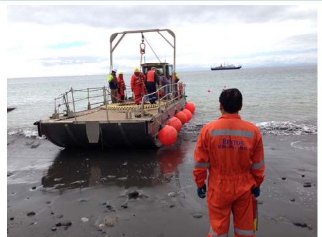
Transporte del cable desde tierra a buque cablero.
