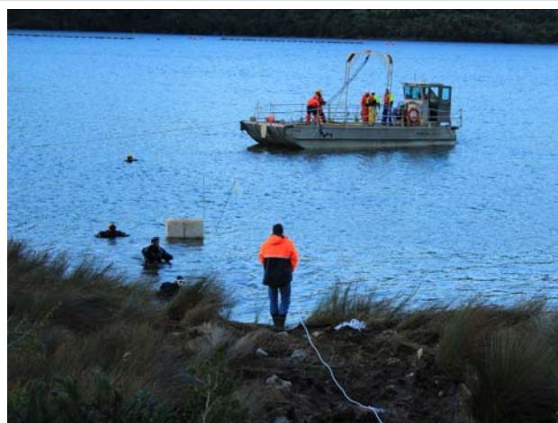
Buzos inspeccionando la instalación del cable.
