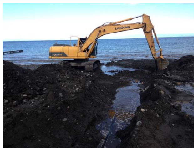
Enterrando el Cable – Quellón.
