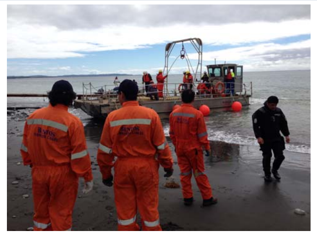
Maniobra de traslado del cable hacia tierra.
